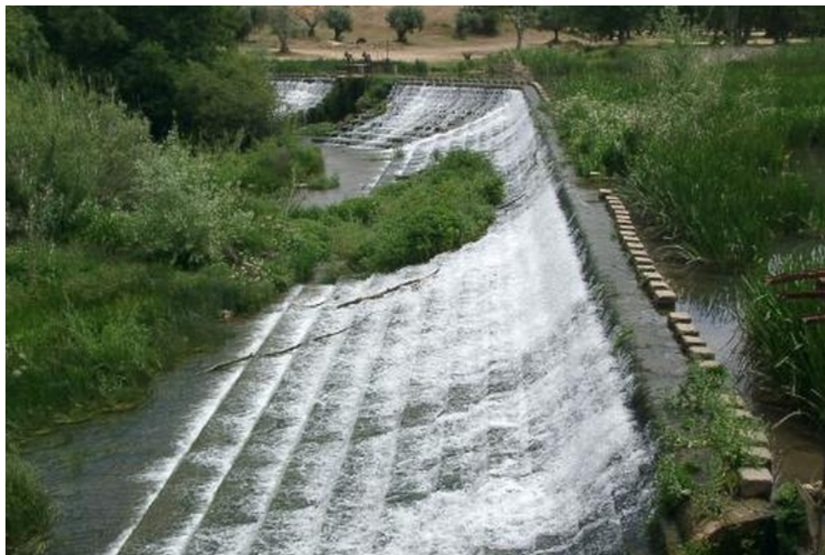
Imagem 104 – Açude da Fábrica de Fiação de Tomar
