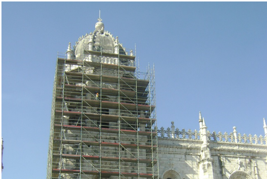
Imagem 89 – Ação de conservação de património edificado
