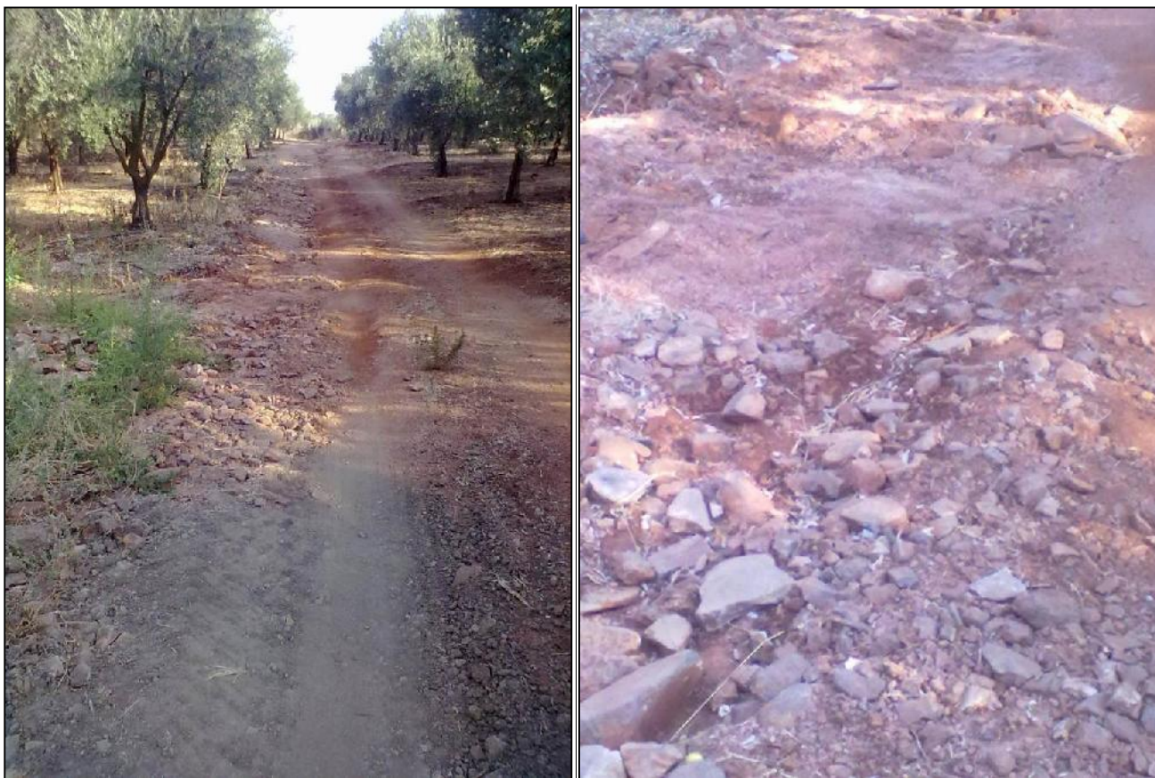
Fig. 22 – Estabilização de linhas de escorrência para combater a erosão do solo.
