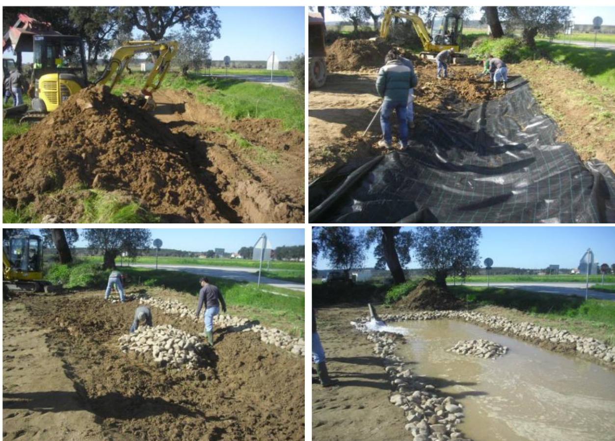
Fig. 5 - Construção de um charco
