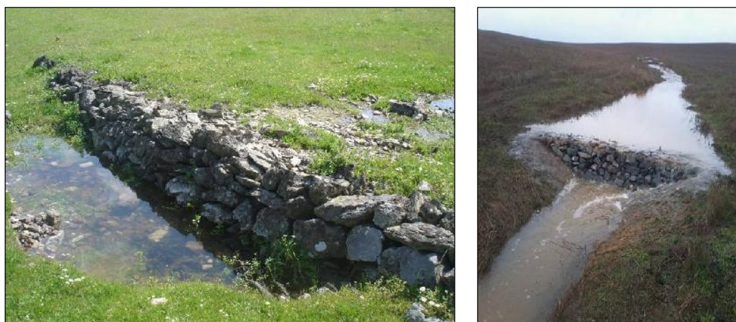
Fig. 7 – Muretes de pedra em linhas de escorrência de água em terrenos muito suscetíveis à erosão.
